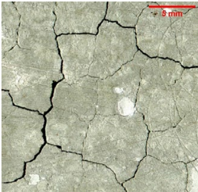
Rys. 1. Fragment spękanego powierzchni matrycy cementowej po drugiej fazie obciążenia termicznego – 450°C
