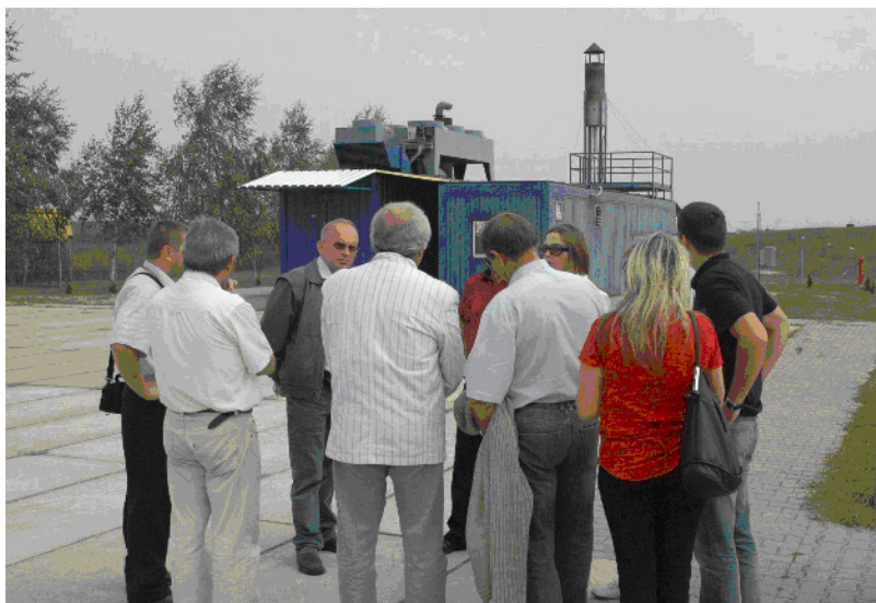
Obiekt ekoenergetyczny w postaci generatora zasilanego biogazem na terenie składowiska odpadów w Rokietnicy
