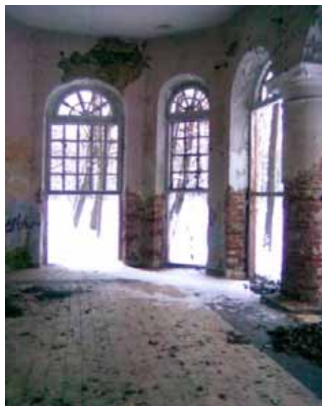
Ryc. 7. Widok wnętrza oranżerii w Cieleśnicy (fot. E. Rudnicka 2009)
