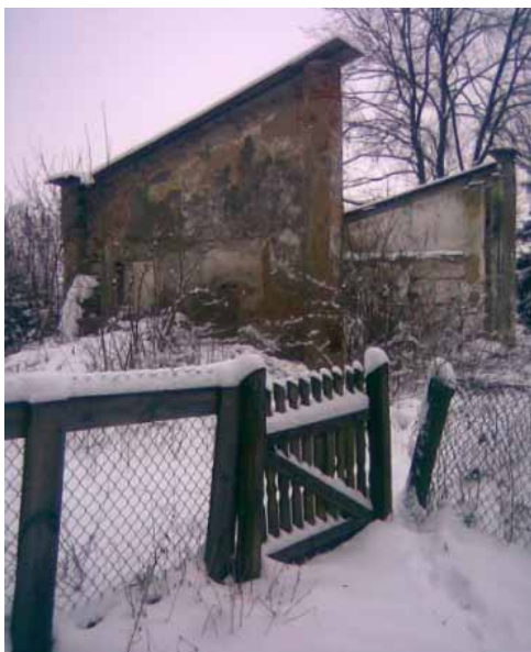
Ryc. 8. Widok na zachodnią elewację oranżerii w Witulinie (fot. E. Rudnicka 2009)
