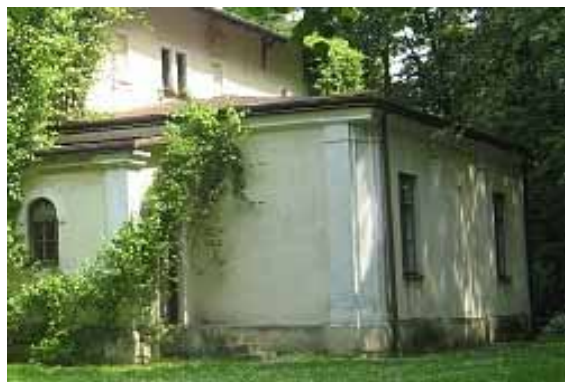
Ryc. 1. Widok na zachodnią i południową elewację ogrodu zimowego w Milanowie (fot. E. Rudnicka 2009)
