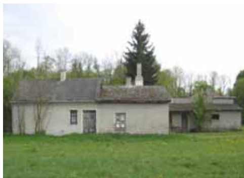
Ryc. 8. Dawna oranżeria. Obecnie budynek mieszkalny (fot. E. Rudnicka, 2009)
