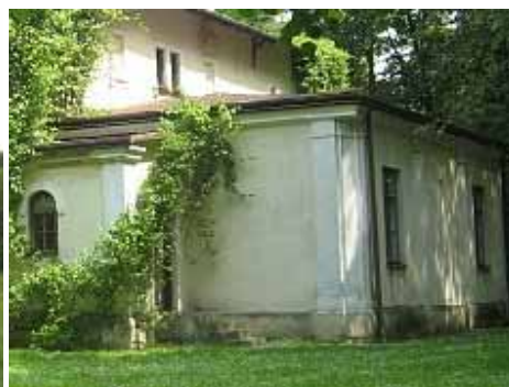
Ryc. 9. Wejście do kotłowni przy dawnym ogrodzie zimowym. Widok współczesny (fot. E. Rudnicka, 2009)
