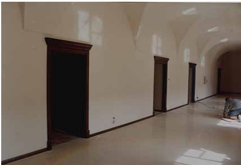
Fot. 8. Klasztor oo. Paulinów we Włodawie. Korytarz po restauracji (fot. A. Białkiewicz) Phot. 8. Paulines' monastery in Włodawa. Corridor after restoration (phot. A. Białkiewicz)
