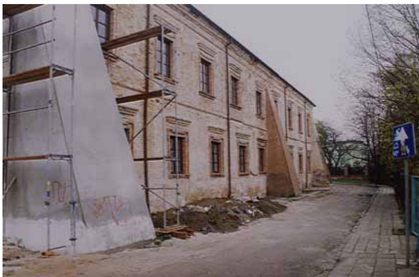
Fot. 5. Klasztor oo. Paulinów we Włodawie. Elewacja wschodnia przed restauracją (fot. A. Białkiewicz) Phot. 5. Paulines' monastery in Włodawa. East elevation before restoration (phot. A. Białkiewicz)
