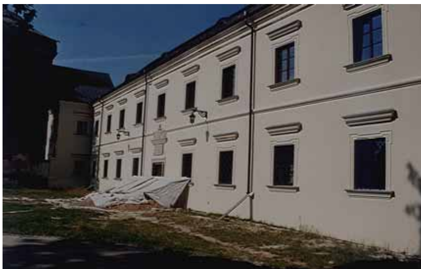
Fot. 6. Klasztor oo. Paulinów we Włodawie. Elewacja południowa w trakcie restauracji (fot. A. Białkiewicz) Phot. 6. Paulines' monastery in Włodawa. South elevation during restoration (phot. A. Białkiewicz)
