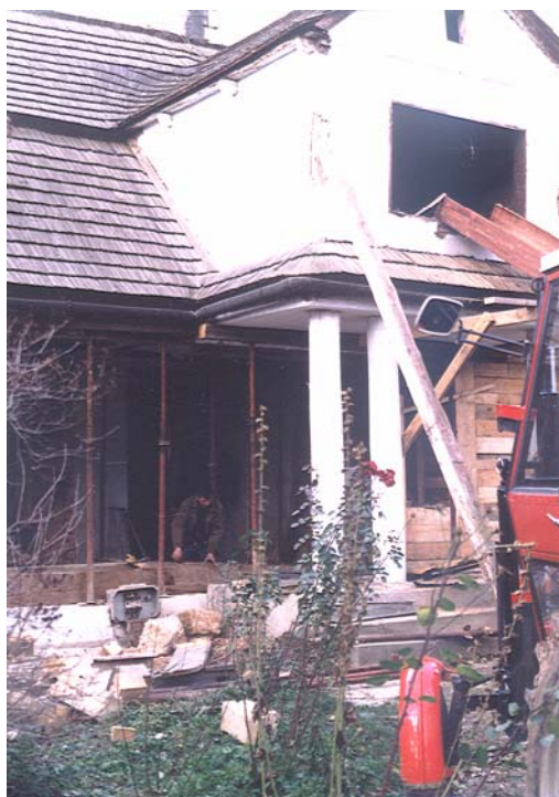
Fot. 4. Tetmajerówka w czasie remontu. Fot. Autora
