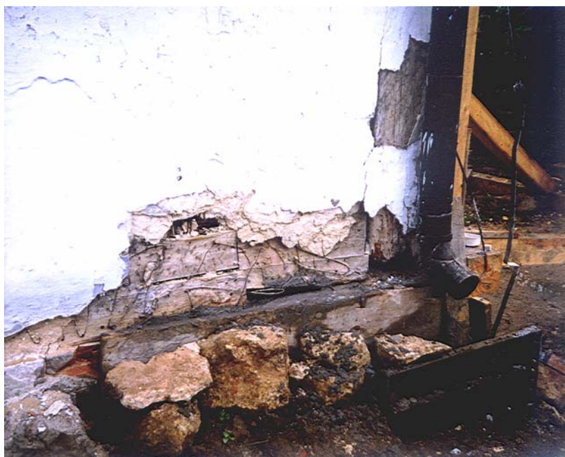
Fot. 5. Tetmajerówka w czasie remontu. Fot. Autora
