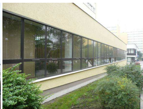
Ryc. 3. Politechnika Lubelska –Wydział Budownictwa; detal (fot. autor)
