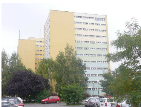
Ryc. 4. Politechnika Lubelska – akademiki: budynek (fot. autor)
