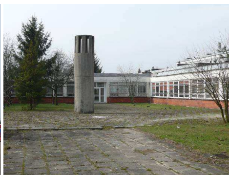
Ryc. 15. Politechnika Białostocka – budynki dydaktyczne – detale (fot. autor)
