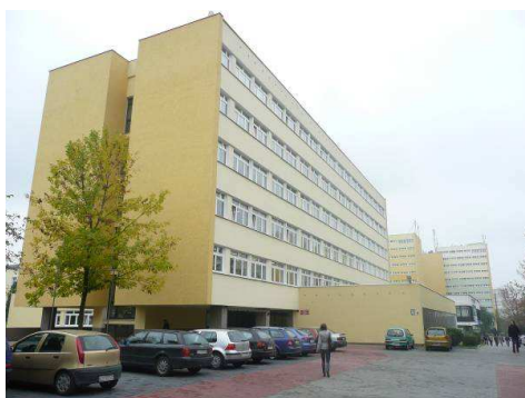
Ryc. 2. Politechnika Lubelska –Wydział Budownictwa; budynek (fot. autor)
