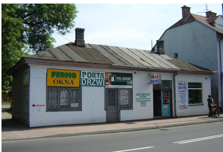
Ryc. 1. Budynek po dawnej szkole rosyjskiej w Międzyrzeczu Podlaskim przy ul. Warszawskiej 12 (fot. G. Rola, Ł. Pękała)
