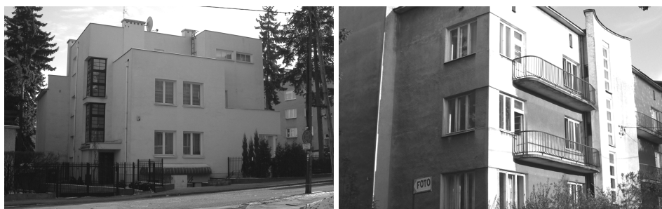
Ryc. 11. Zabudowa mieszkaniowa w tzw. dzielnicy oficerskiej przy ul. Głowackiego (fot. N. Przesmycka)
