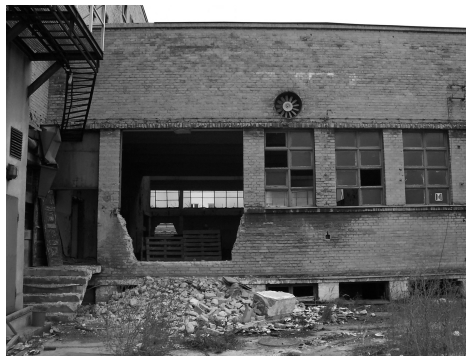
Fot. 9. Maszynownia chłodni składowej 2006 r., fot. zbiory prywatne
