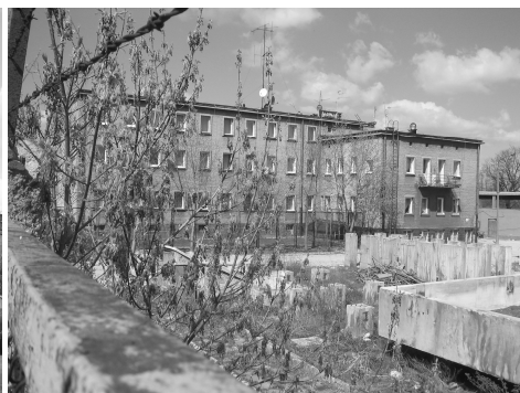
Fot. 5. Budynek biurowy zespołu chłodni przy zakładach mięsnych: widok od południa, fot. autorki
