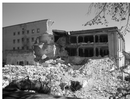
Fot. 11. Chłodnia składowa, widok od strony zachodniej 2007 r., fot. autorki
