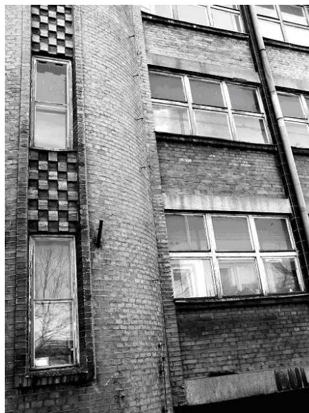
Fot. 7. Budynek biurowy zespołu chłodni przy zakładach mięsnych: fragment elewacji
