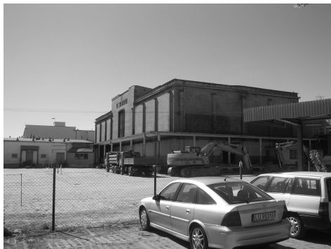
Fot. 8. Chłodnia składowa, widok od strony wschodniej 2006 r., fot. autorki
