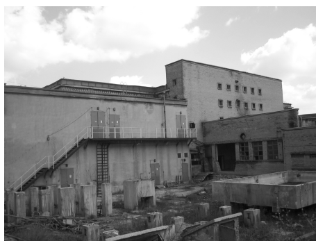
Fot. 10. Chłodnia składowa, widok od strony zachodniej 2006 r., fot. autorki
