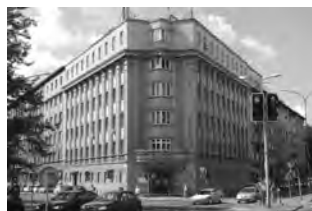
Fot. 24. Wydział Powiatowy Phot. 24. The building of County Department
