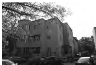
Fot. 35. Kamienica przy ulicy Włóczyków 20 Phot. 35. The tenement at 20 Włóczyków St.
