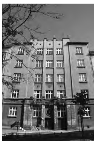
Fot. 14. Kamienica „Pod Pszczółkami” Phot. 14. The Tenement „Under Bees”
