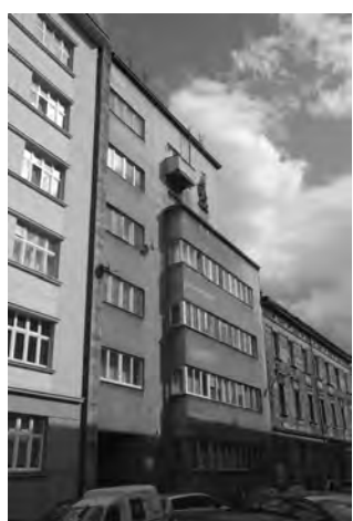
Fot. 13. Budynek przy ul. Lenar- towicza 13 Phot. 13. The building at 13 Lenartowicz St.
