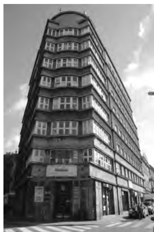
Fot. 27. Biurowiec Komunalnej Kasy Oszczędności Phot. 27. The Office block of the Council Safe of the Frugality
