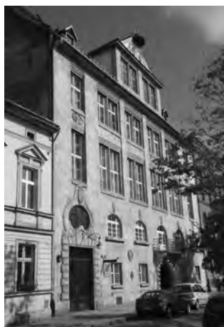
Fot. 1. Gmach Muzeum Techniczno-Przemysłowego (fot. 1–36 Farid Nassery) Phot. 1. The building of the Technical-Industrial Museum (phot. 1–36 Farid Nassery)
