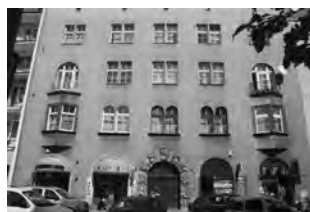
Fot. 9. Budynek przy ul. Lea 17 Phot. 9. The building at 17 Lea St.
