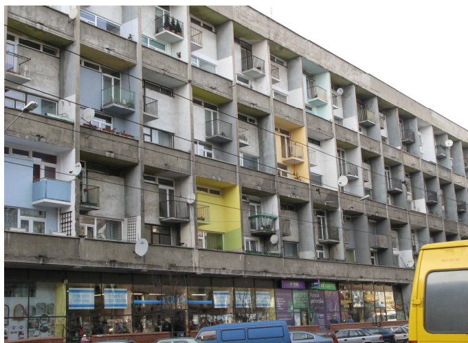
Ryc. 5. Dom galeriowy, ul. Kołłątaja, Wrocław, arch. Jadwiga Grabowska-Hawrylak, 1960. Fot. B. Dubik, 2008.
