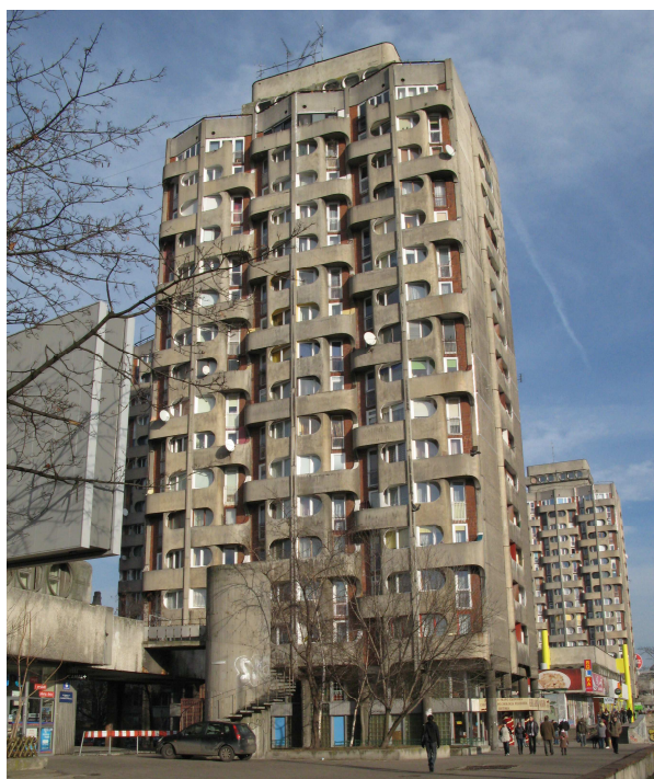
Ryc. 4. Wieżowce mieszkalne, pl. Grunwaldzki, Wrocław, arch. Jadwiga Grabowska-Hawrylak, 1970. Fot. B. Dubik, 2008.
