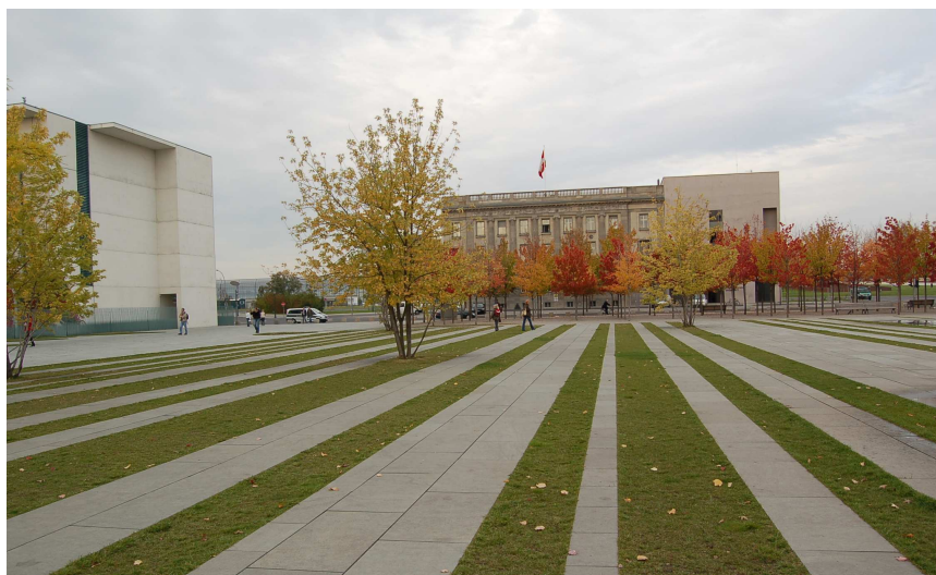
Ryc. 13. Założenie budynków rządowych „Band des Bundes” – Berlin – widok; źródło: zdjęcie autorki
