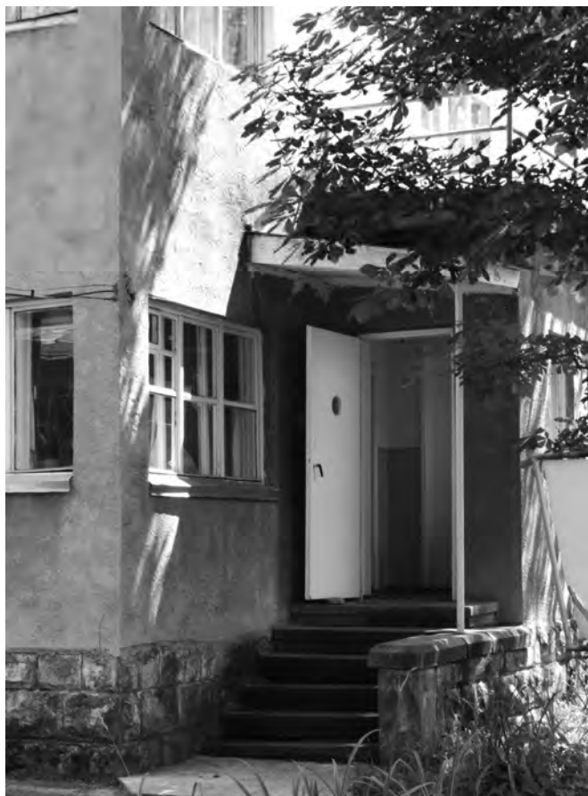
Ryc. 23. Worochta. Willa modernistyczna w dzisiejszym zespole budynków sanatorium „Smericzka”. Główne wejście do budynku, 2007 (fot. autor)
