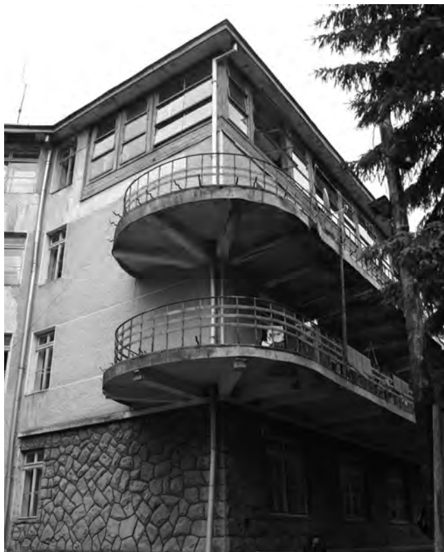
Ryc. 16. Worochta. Sanatorium Kas Chorych, modernistyczne skrzydło powstałe po 1933 r., 2008 (fot. M. Kulikowska)
