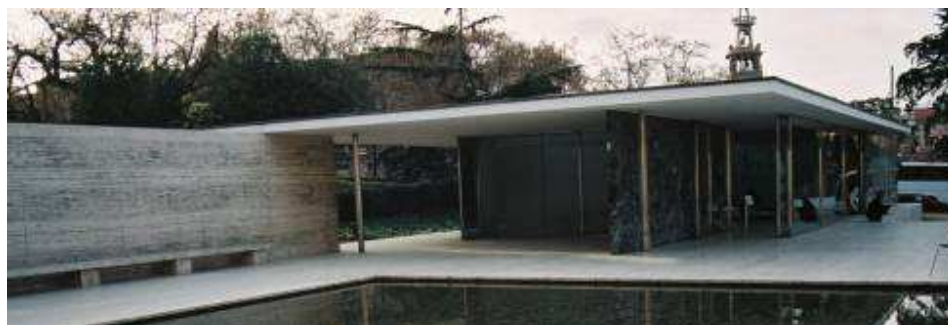
Ryc. 4. Barcelona, Pawilon niemiecki (Mies van de Rohe), widok założenia, zdjęcie autorów
