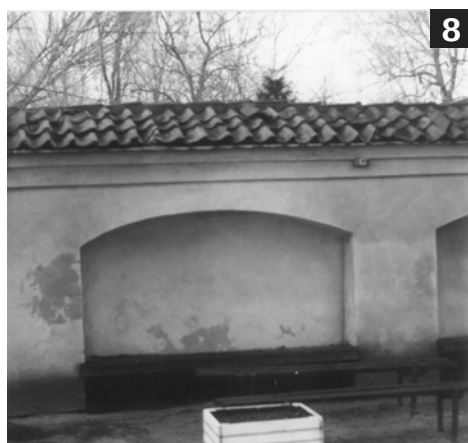
Rys. 8. Fragment ogrodzenia kościelnego, Sosnowica (fot J. Zamasz)
