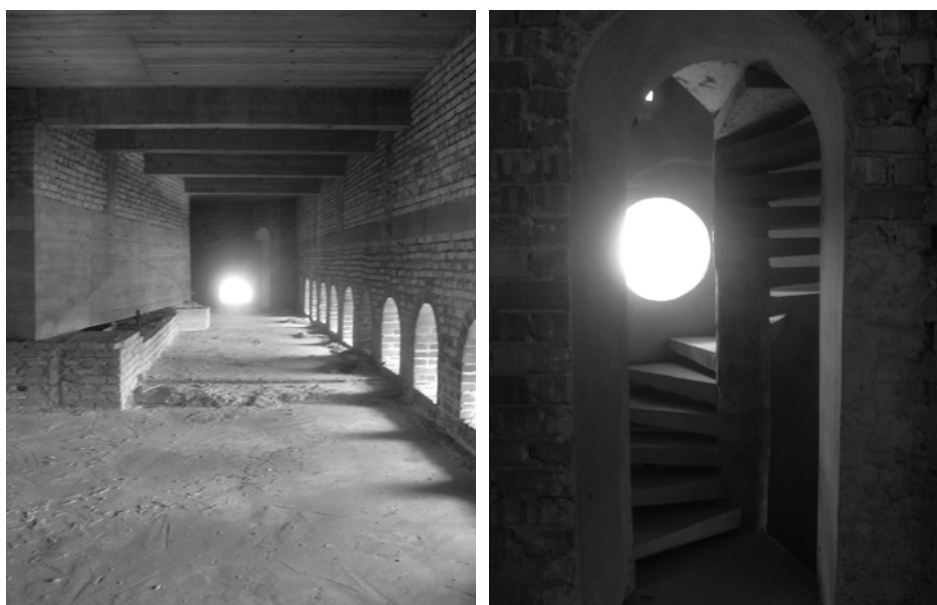
Rys. 10, 11. Cerkiew Zwiastowania NMP po rekonstrukcji – widoki żelbetowej konstrukcji nad głównym sklepieniem i stropem oraz konstrukcji klatki schodowej w jednej z wież (fot. A. Tokajuk)
