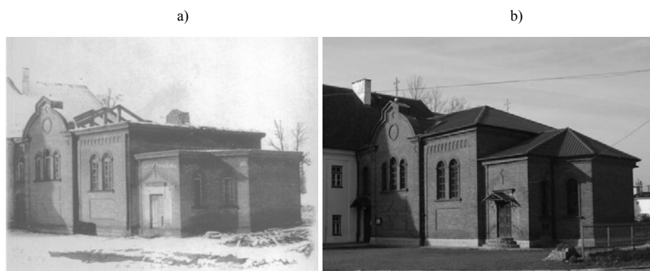
Rys. 12. Cerkiew św. Jana Teologa: a – stan z roku 1957 [Makal 2003], b – stan z roku 2006 (fot. A. Tokajuk)
