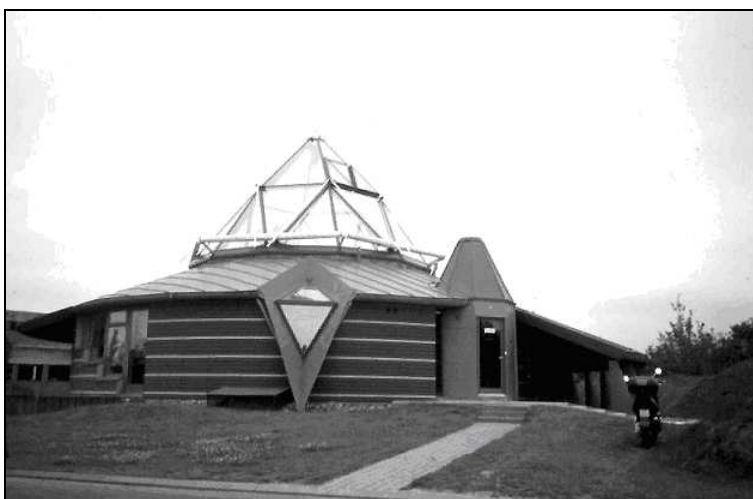
Fot. 2. Villa Vision w Kopenhadze, Dania – eksperymentalny obiekt z pasywnym i aktywnym wykorzystaniem energii słonecznej (fot. autorka)
