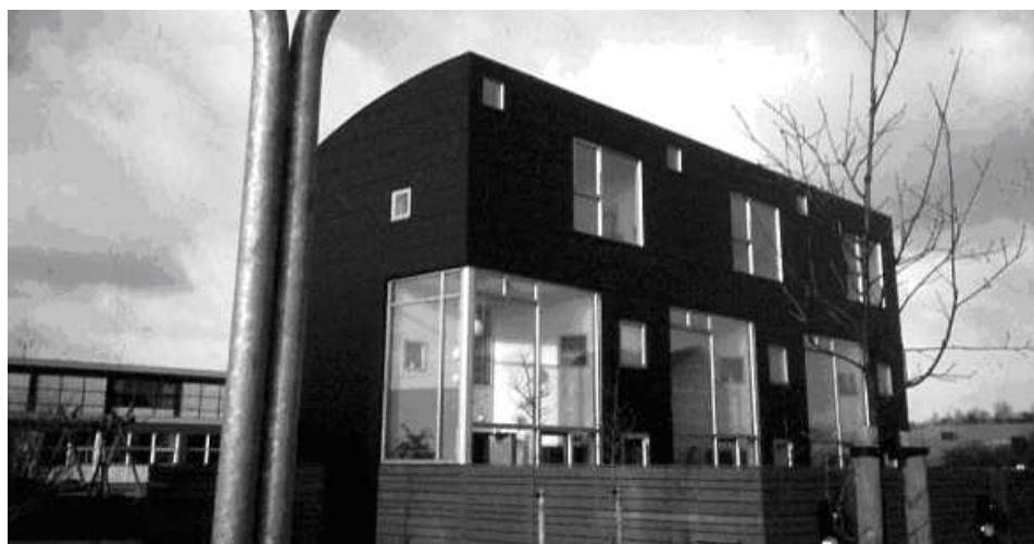
Fot. 4. Zespół mieszkaniowy Bo 01 City of Tomorrow w Malmö, Szwecja, przykład architektury z kolektorami słonecznymi (fot. autorka)
