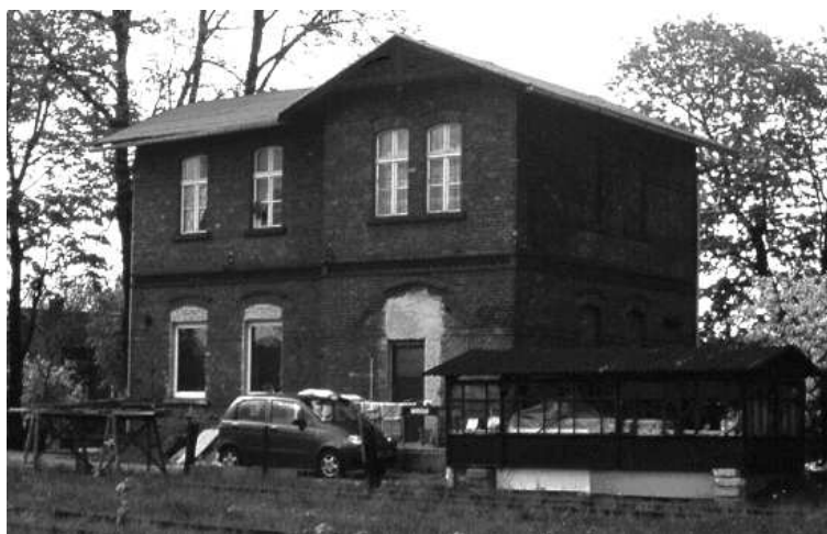
Ryc. 1. Kamieniec Ząbkowicki. Budynek mieszkalny będący przykładem typowej dla końca XIX i początku XX w. kolejowej architektury ceglanej o skromnym, lecz starannie opracowanym detalu. Na parterze wstawiono używane okna i drzwi, do których dostosowano rozmiary otworów w ścianach (fot. autor)
