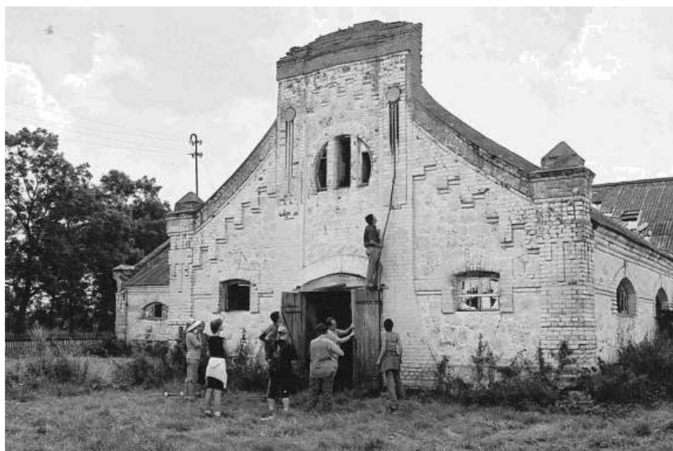
Rys. 6. Praca zespołu inwentaryzującego budynek stajni, 2002 r. (fot. Stepaniuk)
