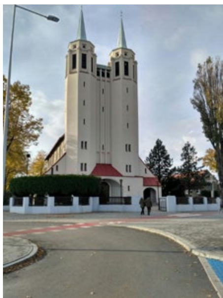
Ryc. 10. Elewacja wschodnia z dwoma wieżami.
