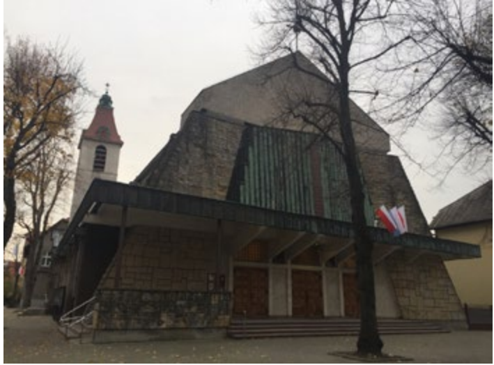
Ryc. 7. Przebudowana elewacja północna.
