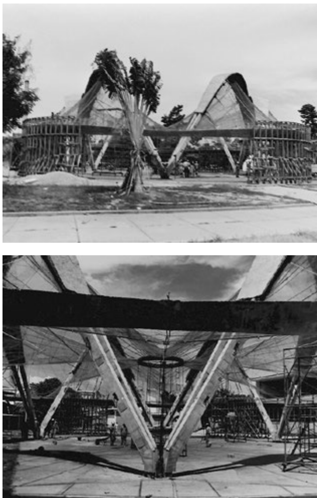
Ryc. 2. Ryc.2 i 3 System konstrukcyjny podparcia powłoki
