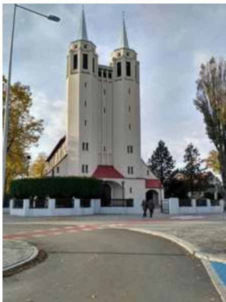
Ryc. 10. Elewacja wschodnia z dwoma wieżami.
