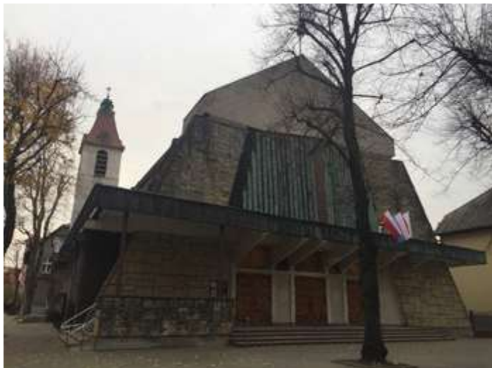
Ryc. 7. Przebudowana elewacja północna.
