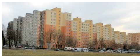
Ryc.14. Hamasie 21/Zakopiańska 1. Budynek prefabrykowany z 1986r. po ociepleniu w latach 90. i częściowej wymianie stolarki okiennej. Widok ogólny od strony północno-wschodniej
