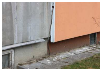
Ryc.18. Fragment budynku prefabrykowanego na styku I i II etapu ocieplenia. Zły stan płyt okładzinowych i stolarki okiennej, brak ocieplenia cokołu w obu etapach ocieplenia
