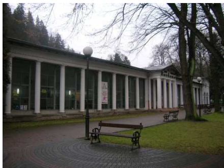
Ryc.3. Hala spacerowa w Dusznikach-Zdroju, (fot. M. Piróg)
