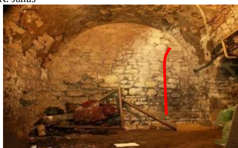
Ryc. 12. Piwnica, część C, widok na ścianę wschodnią z zaznaczeniem zamurowanego otworu. Fot. K. Janus
