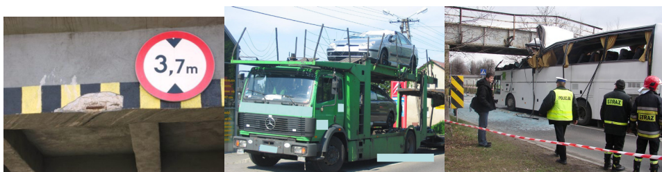
Rys. 2. Przykład uszkodzeń obiektu i pojazdu w wyniku przekroczenia wysokości pojazdu w stosunku do skrajni
