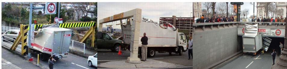
Rys. 1. Przykład uszkodzenia w wyniku przekroczenia wysokości pojazdu w stosunku do skrajni
