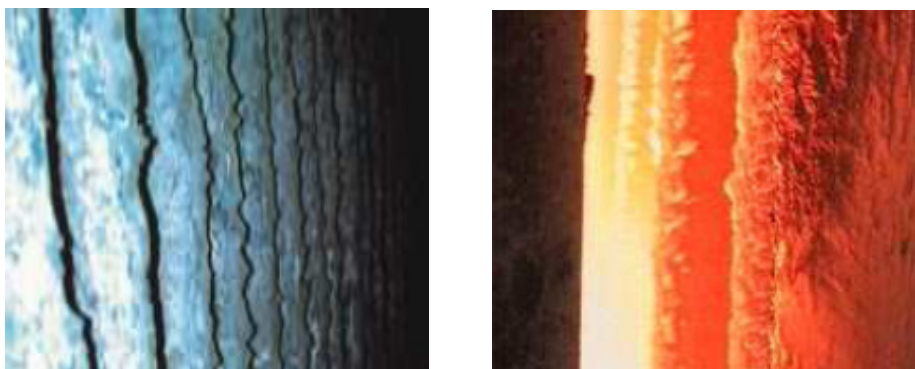
Rys. 4. Fragmenty przegrzewacza pokryte osadami i produktami korozji wysokotemperaturowej
