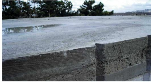
Рис. 1. Монолитная пенобетонная трехслойная плита перекрытия
