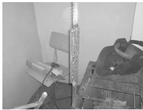
Рис.7. Медленное остывание сварного стыка Fig.7. Slow cooling of the welded joint
