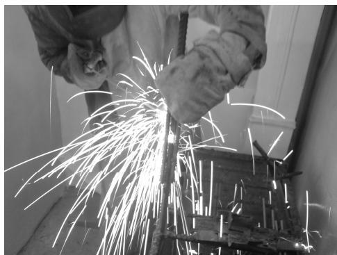
Рис.6. Заварка стыка в вертикальном положении Fig.6. Welding joint in the upright
