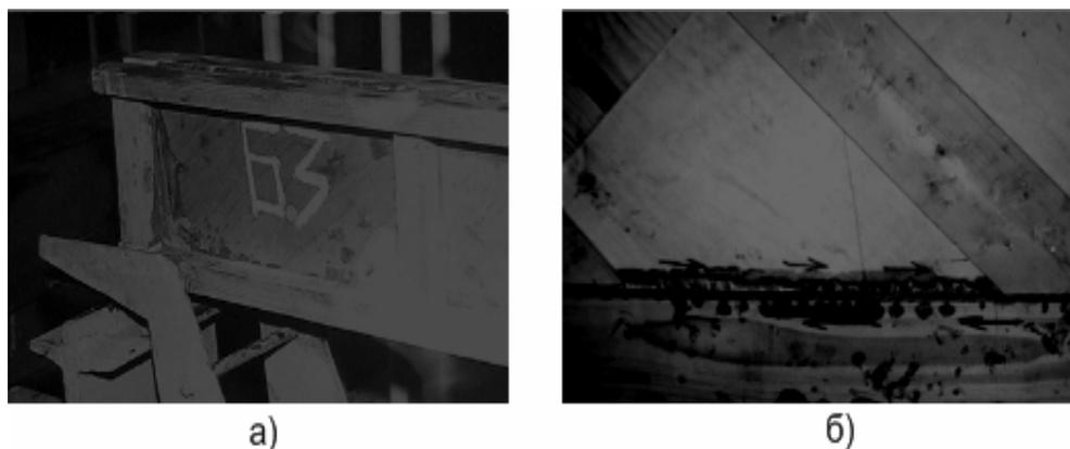
Рис. 11. Разрушение клеевых швов соединения стенки с поясами:
