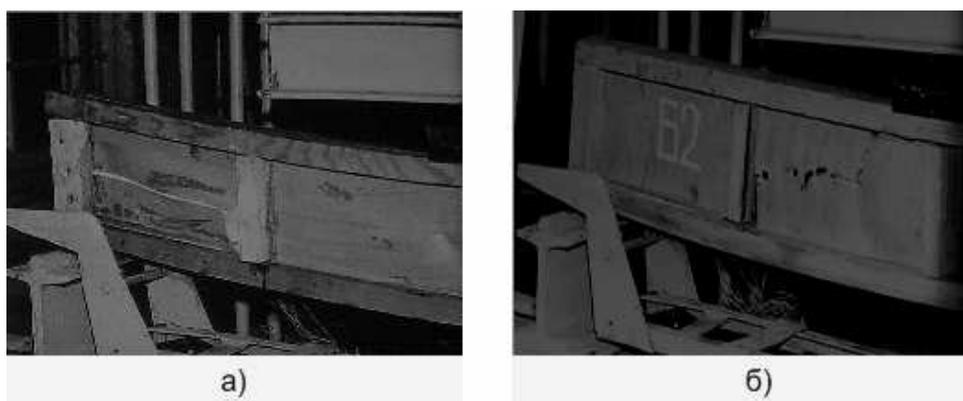
Рис. 10. Разрушение фанеры в опорной панели:
