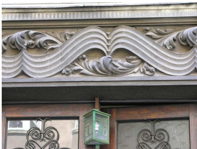
Ryc. 4. Fryz nad parterem kamienicy przy ul. Chopina 4 (fot. B. Makowska)
