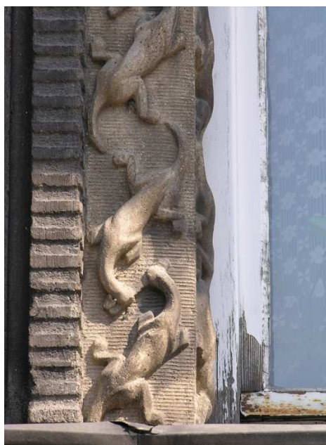
Ryc. 2. Obramienie okna kamienicy przy al. Słowackiego 58 (fot. B. Makowska)
