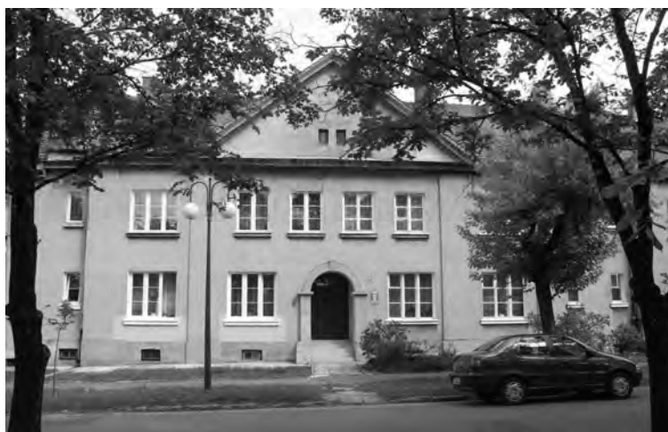
Ryc. 14. „Dyrekcja górna”, widok wejścia do budynku (fot. autor)
