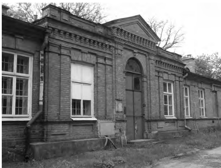
Ryc. 2. Zabudowa szpitala wojskowego, obecnie budynki opuszczone (fot. autor)
