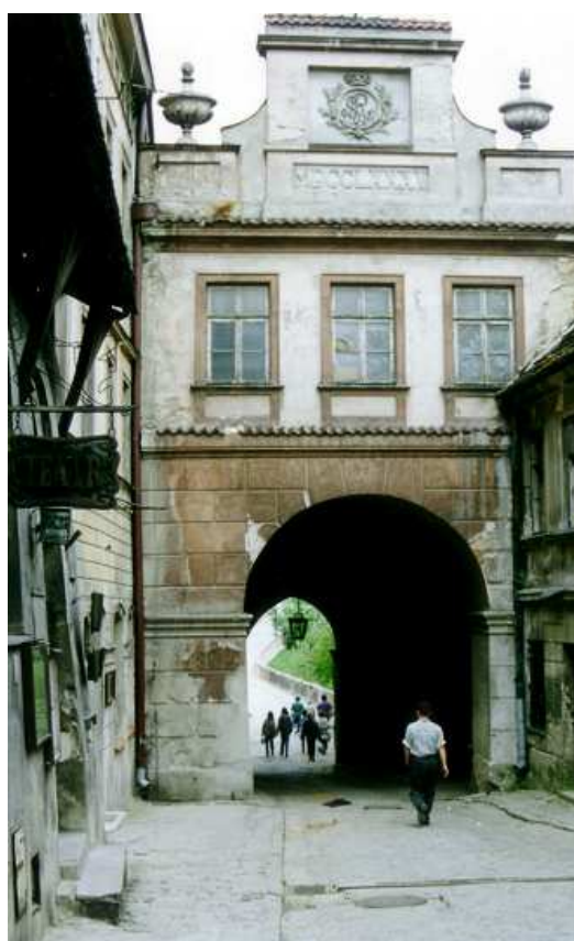
Rys. 1. Brama Grodzka, fasada od strony Starego Miasta, stan przed remontem (fot. M. Kubiszyn)
