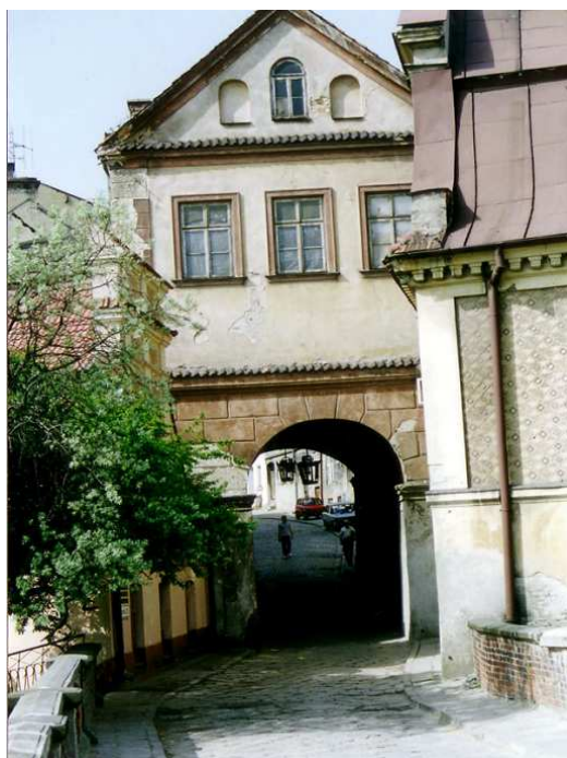
Rys. 2. Brama Grodzka, fasada od strony dawnej dzielnicy żydowskiej, stan przed remontem (fot. M. Kubiszyn)
